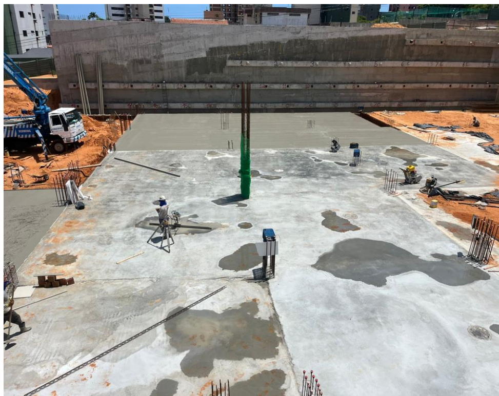
Figura 6. Concretagem da laje de piso do segundo subsolo.
