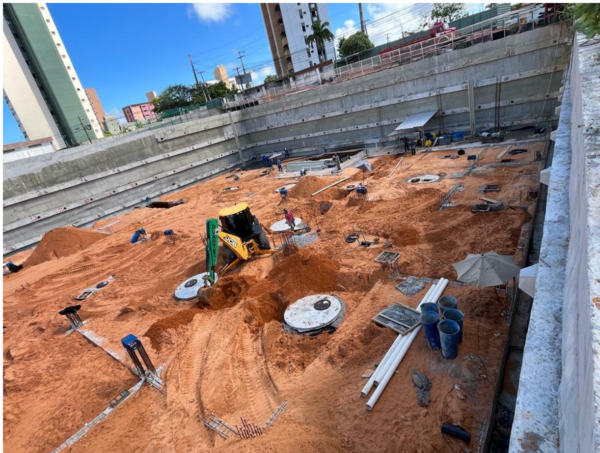
Figura 8. Execução dos poços de infiltração para captação das águas pluviais.
