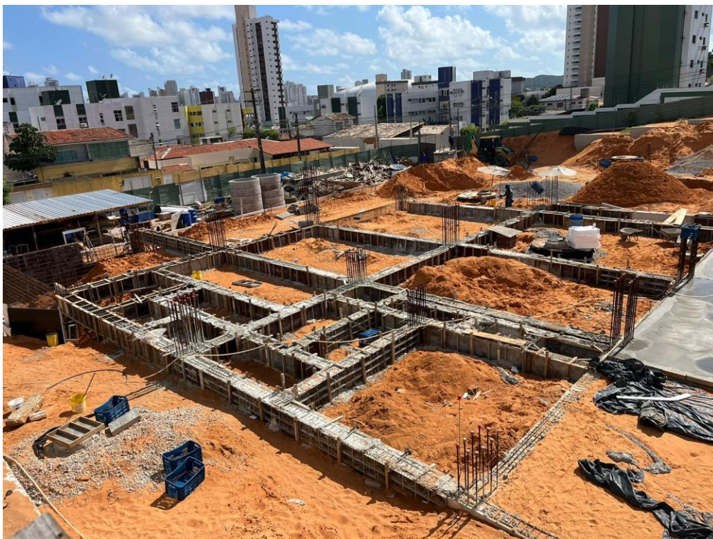
Figura 4. Montagem e concretagem das vigas baldrame.
