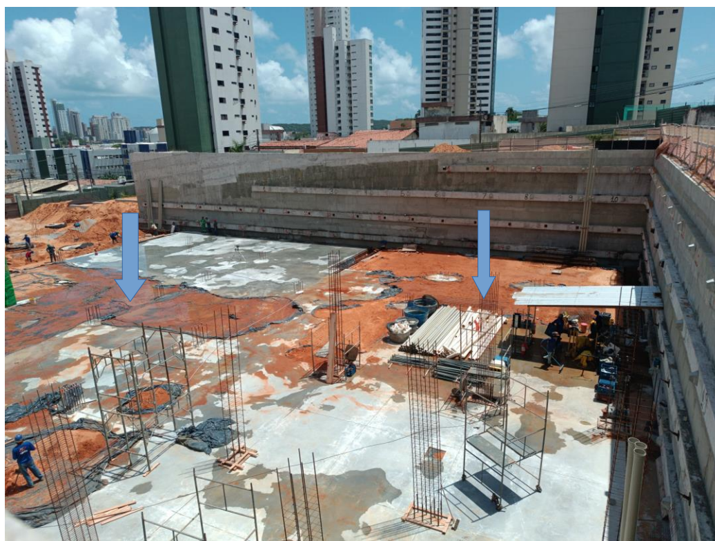
Figura 7. Laje de piso do segundo subsolo, resfriamento realizado utilizando água, lona e areia .
