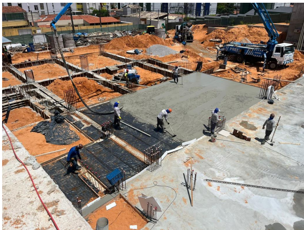
Figura 5. Vigas baldrame e lajes de piso.
