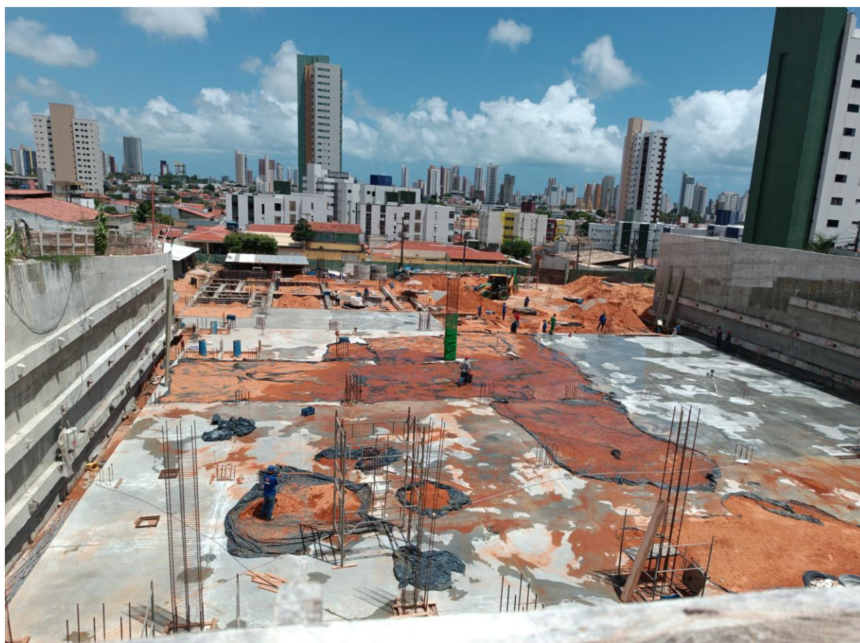
Figura 1. Visão geral da obra.
